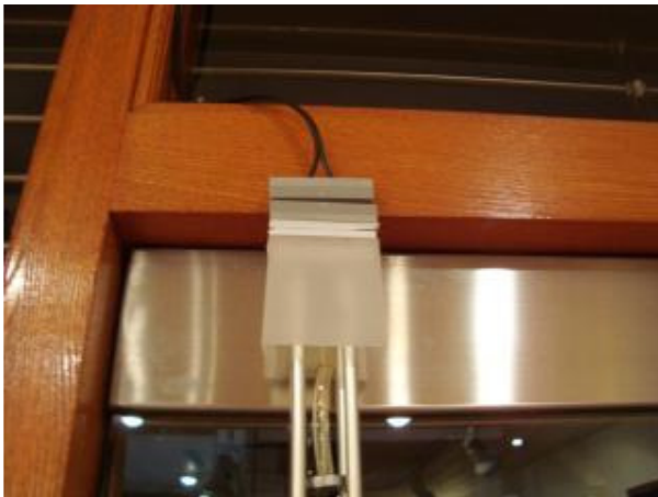
入口ドアにマグネットセンサー、店内に威嚇しないよう、ファッションブルカメラ設置
