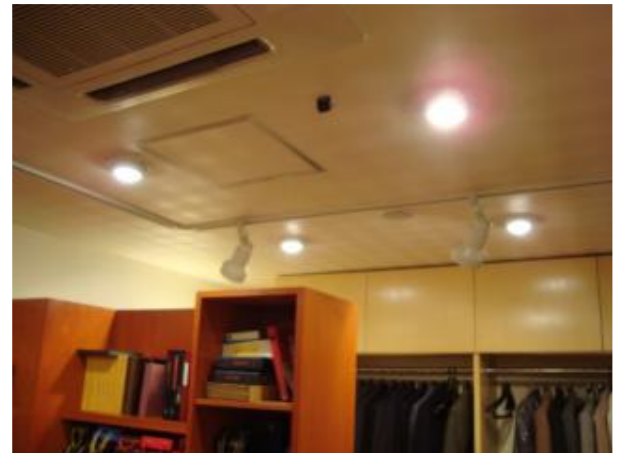
入口ドアにマグネットセンサー、店内に威嚇しないよう、ファッションブルカメラ設置
